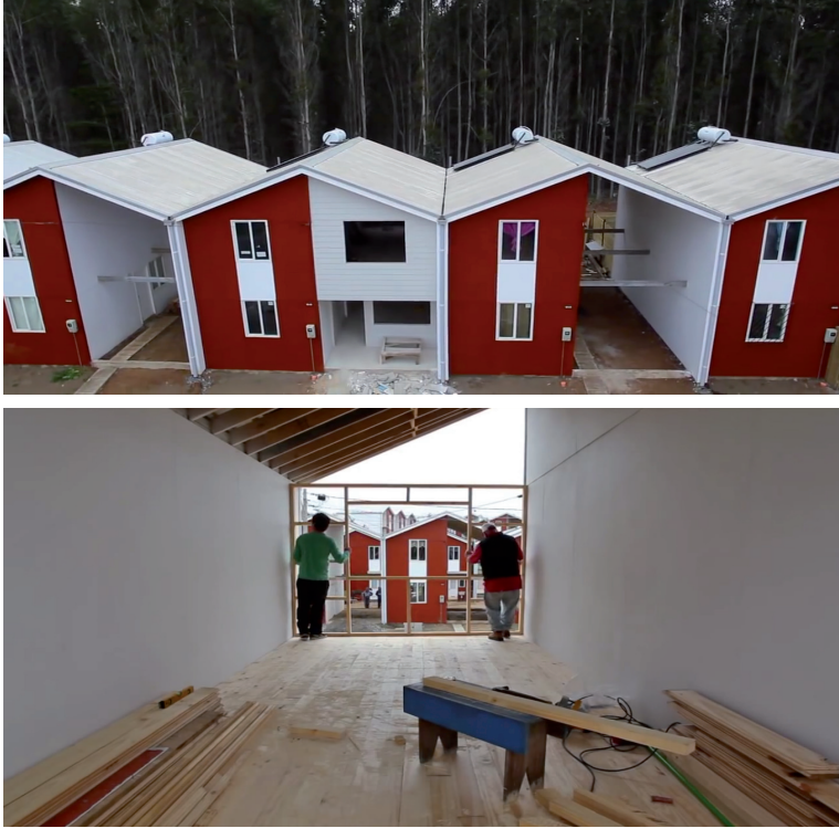
Fig. 6.6 – Ampliamento delle case (Villa Verde, Constitución). In alto: case che hanno raddoppiato la metratura e non. In basso: lavori interni di ampliamento – Fonte: PRES-Constitución
