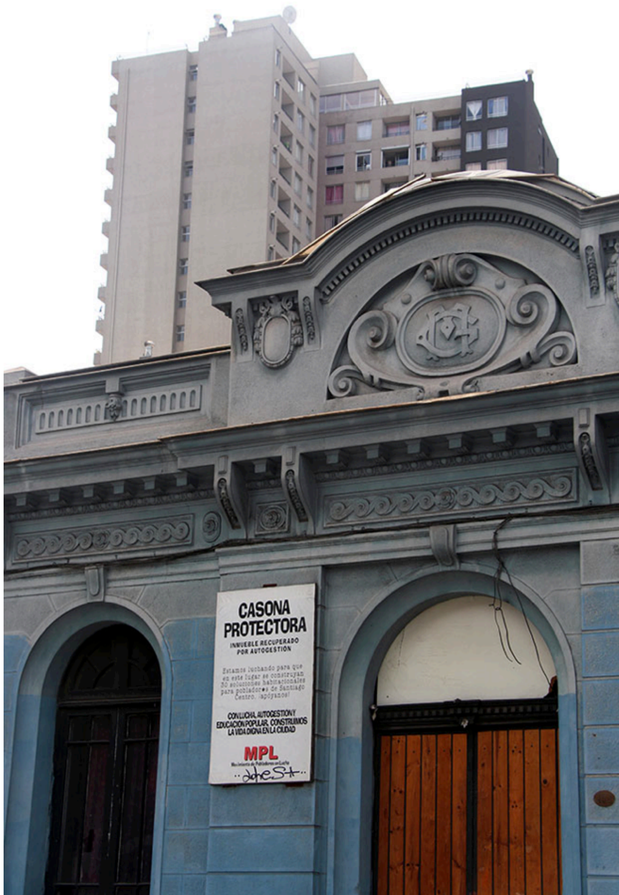
Fig.4 Casona Protectora, in secondo piano un edificio recente. Fonte: elaborazione propria.
